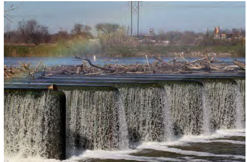
Triangulär Anknäbb Piano Key Weir
